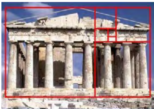
Figura 5: Rectángulos Áureos en la fachada del Partenón.
