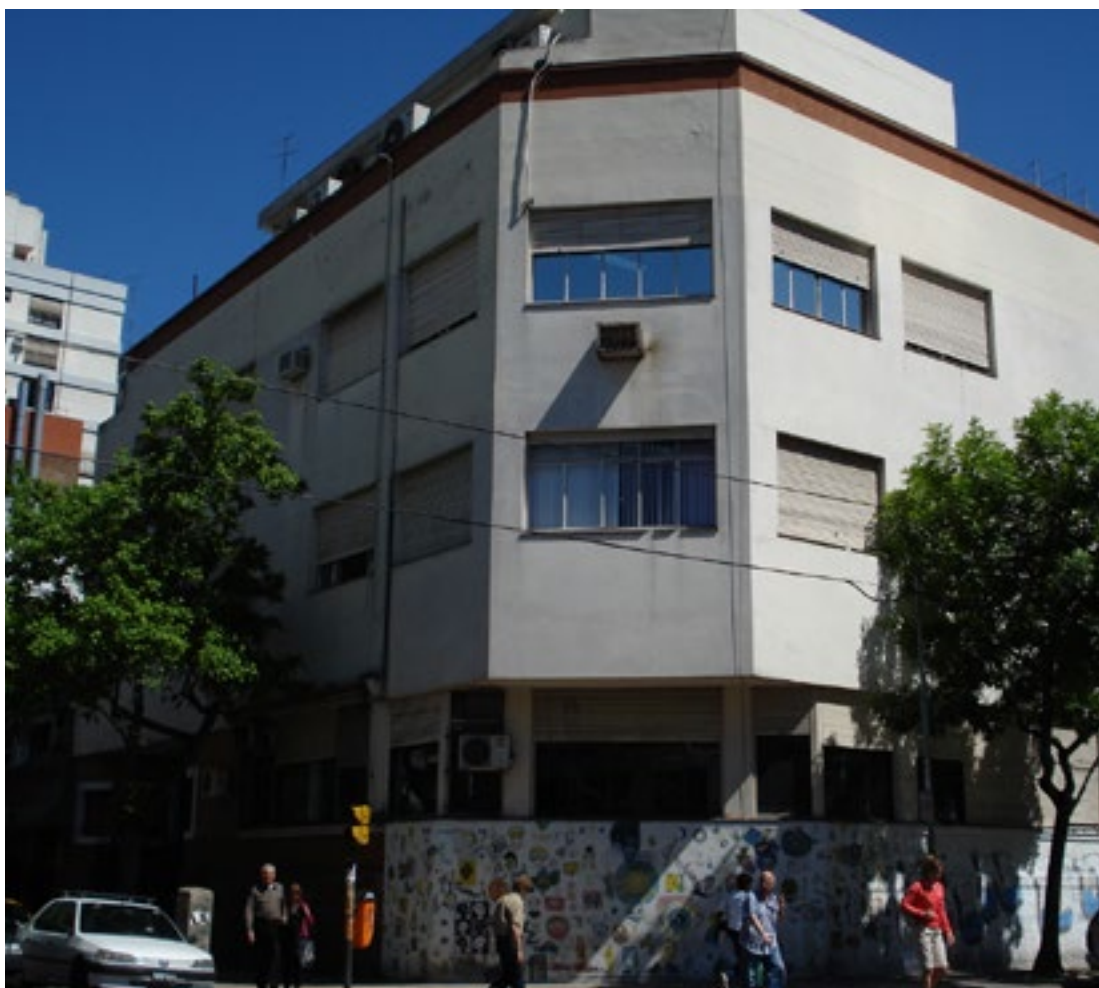
Figura 2: Edificio del Instituto de Biología y Medicina Experimental (IByME)
