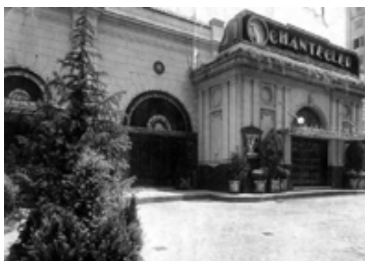
Figura 5: Fachada del Chanteclair .
